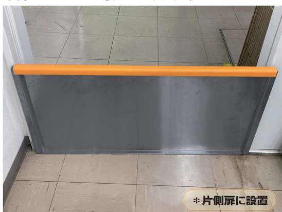
事例3：ステンレス製・レール式・クッション付
