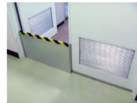
両面扉 (片側のみ) に設置
