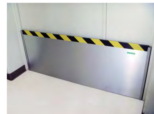
親子扉に設置
