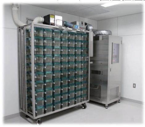
温湿度制御クリーンエアーを提供できる恒温恒湿空調機と、高密度飼育が可能でケージ間クロスコンタミネーションを抑制可能な Lab Products 社製個別換気式飼育装置(IVC ラック)をドッキング。 マウス・ラット等の小規模飼育に最適な組み合わせです。
